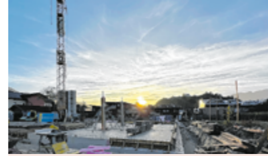
2. Oktober 2023: Das erste Fundament für den Bürokomplex steht.
