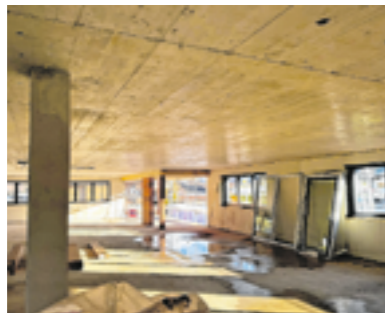
22. November 2023: Fenster und Türen wurden von der Firma Lagerhaus eingebaut.
