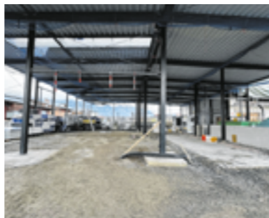
20. Dezember 2023: Die neue Lagerhalle bekommt ihr Dach.
