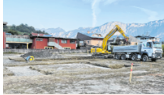
12. September 2023: Die Firma Mauracher beginnt mit den Aushubarbeiten für die Fundamente.
