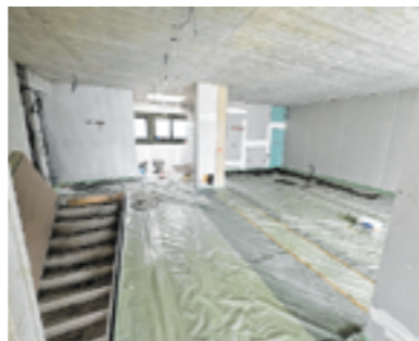
16. März 2024: Der Estrich wird verlegt.
