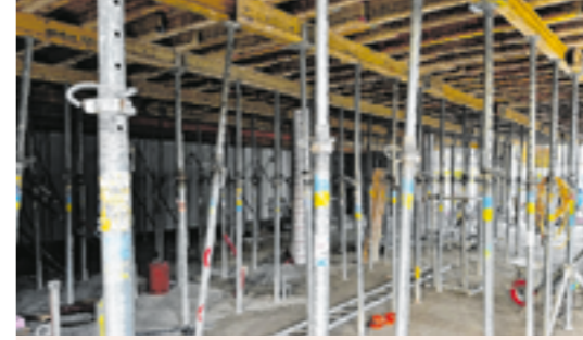
10. Oktober 2023: Die erste Decke wird betoniert.
