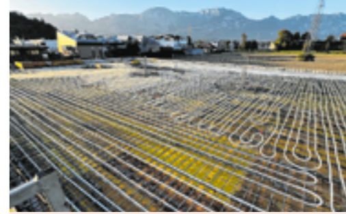
11. Oktober 2023: H&S installiert die Fußbodenheizung.
