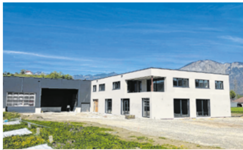
13. April 2024: Die Außenfassade wird fertig gestellt.
