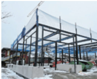
30. November 2023: Firma DHF beginnt mit dem Aufbau der Lagerhalle.
