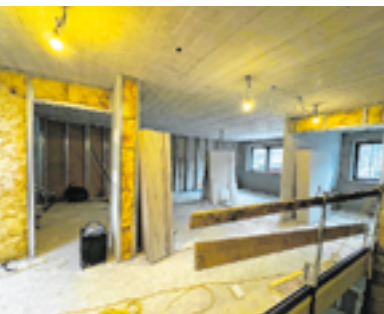
9. Februar 2024: Trotz Eiseskälte beginnt der Innenausbau.
