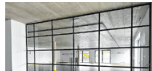
31. Mai 2024: Die exklusiven Glasportale werden von der Firma B&W eingebaut.
