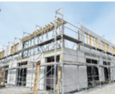
17. Oktober 2023: Die Wände für das Obergeschoß werden angeliefert.
