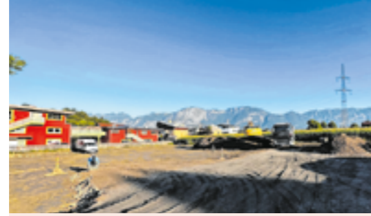
7. September 2023: Die ersten Baufahrzeuge rücken an.
