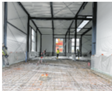
22. Februar 2024: Auch die gesamte Lagerhalle bekommt eine Fußbodenheizung.
